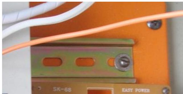
**Figura 4.15 Riel ubicado en el tablero eléctrico**
