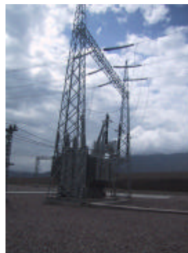
Figura 1- 1. Transformador de tensión Para elevar o disminuir el voltaje para el transporte de energía
