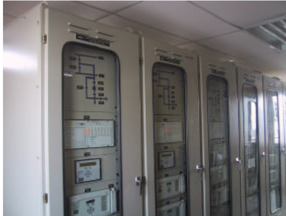
Figura 7- 3. Cubículos de Control de Bahía (S/E Pomasqui)
