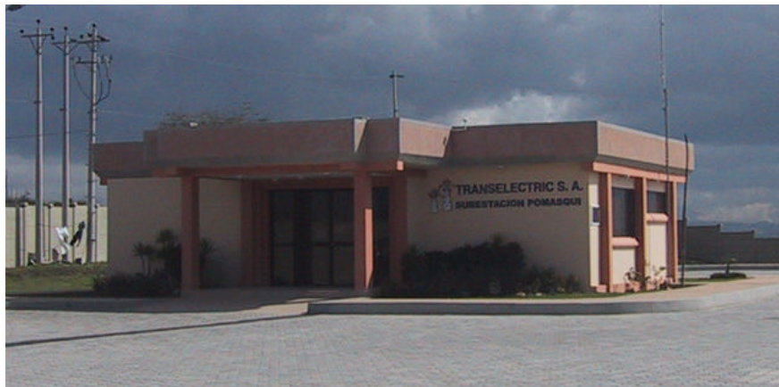
Figura 7- 5. Sala de Control (S/E Pomasqui)
