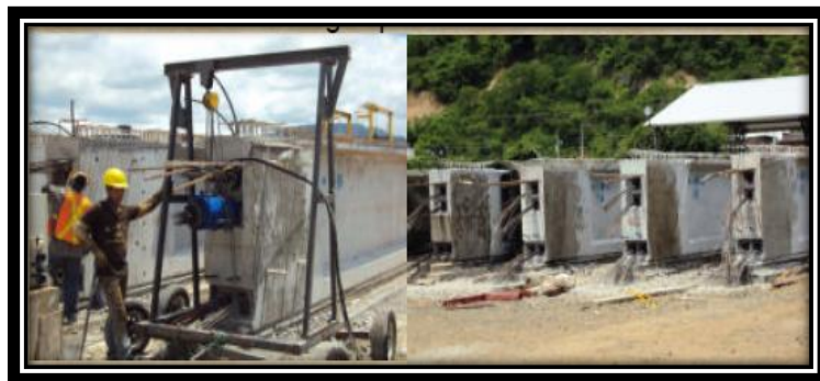
Figura 1.4 Puentes con vigas de hormigón presforzado – pretensado masivo en tierra de vigas para el puente Bahía de Caráquez – San Vicente (Manabí)
