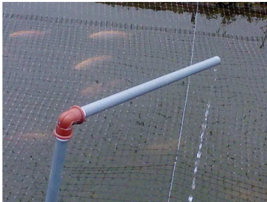
Instalación de agua
