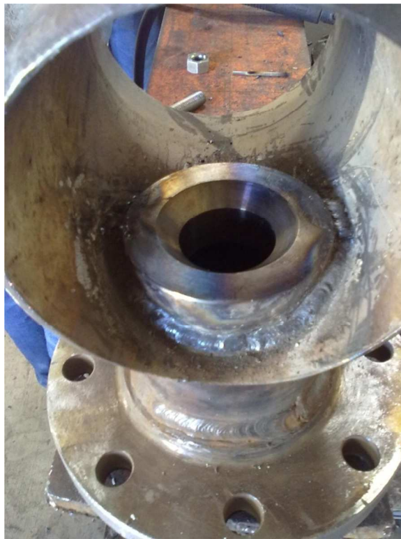
Foto 16: Soldadura de boquilla a cuerpo de válvula para evitar fugas
