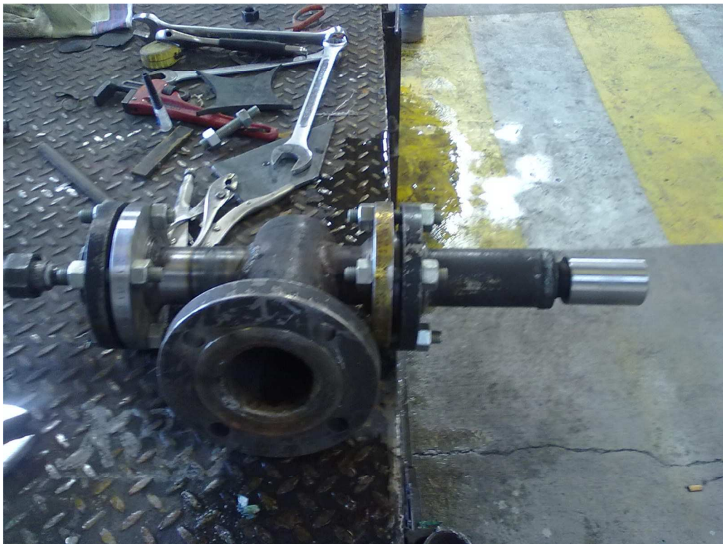
Foto 22: Válvula de 2" conectada a equipo de pruebas
