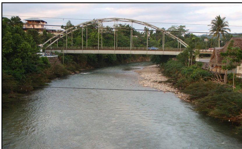
Fig. 2.10 Puente sobre el Rio Masahua, Provincia de Napo (arco sobre tablero)
