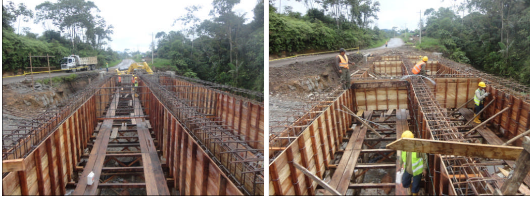
Fig. 6.4 Vigas transversales de hormigón armado
