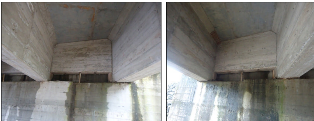
Fig. 6.8 Anclaje vertical en el Puente Montana.
