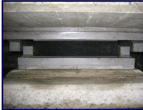
Fig. 6.2 Colocación del neopreno con placas metálicas de sujeción. Puente Marker
