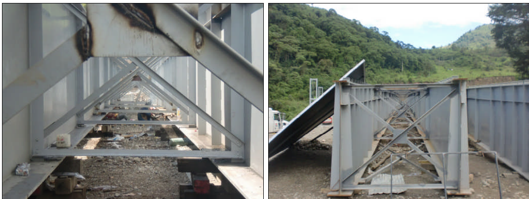
Fig. 6.5 Arriostramientos transversales
