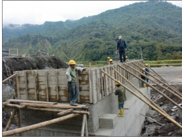
Fig. 6.6 Trabas sísmicas del primer grupo de puentes. Puente Piedra Fina 1
