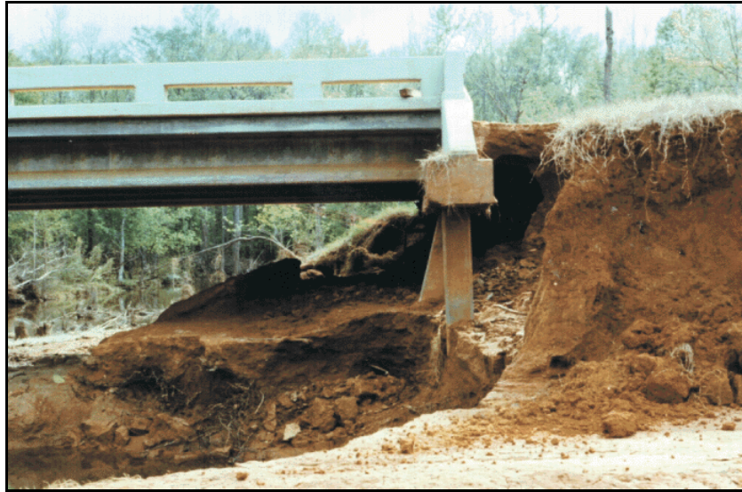
Fig. 2.24 La turbulencia es muy fuerte junto a los estribos
