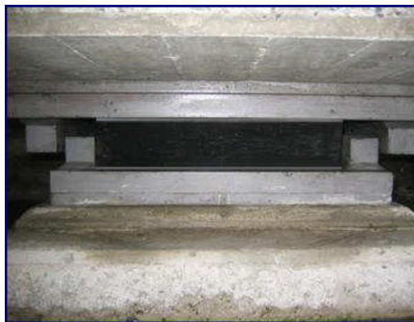
Fig.1.42: Colocación del neopreno con placas metálicas de sujeción. Puente Marker
