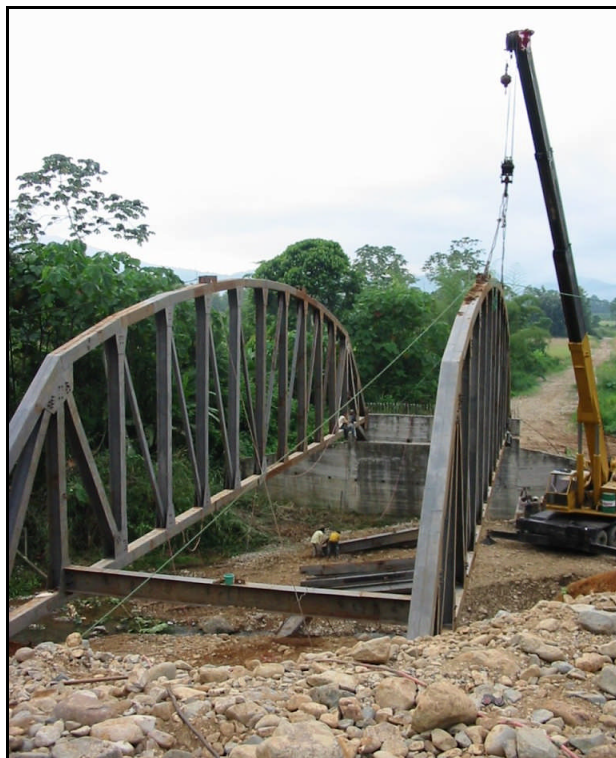
Fig. 2.14 Puente sobre el Río Potosí, Provincia de los Ríos
