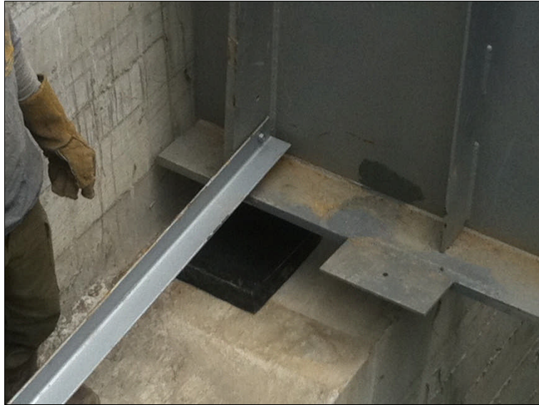
Fig. 6.3 Colocación de las placas de neopreno
