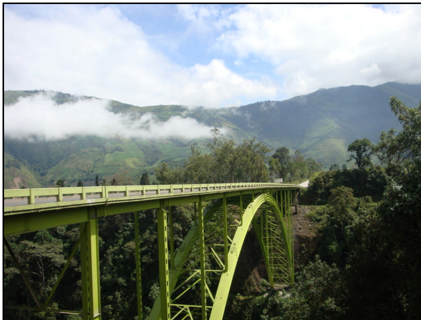
Fig. 2.9 Puente Sal Si Puedes, Provincia de Bolívar (arco bajo tablero)
