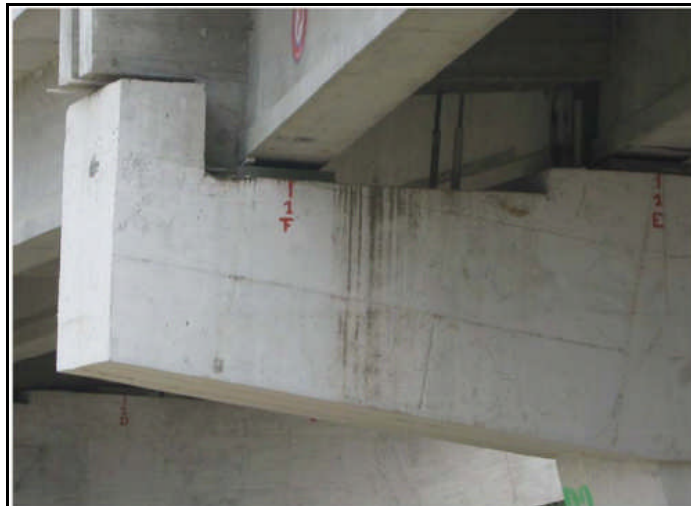
Fig. 4.15 Anclaje Vertical en el Puente de Bahía de Caráquez
