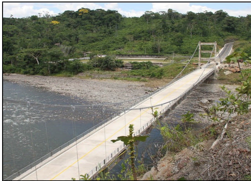
Fig. 2.11 Puente sobre el Rio Napo (carretera E45), Provincia de Napo
