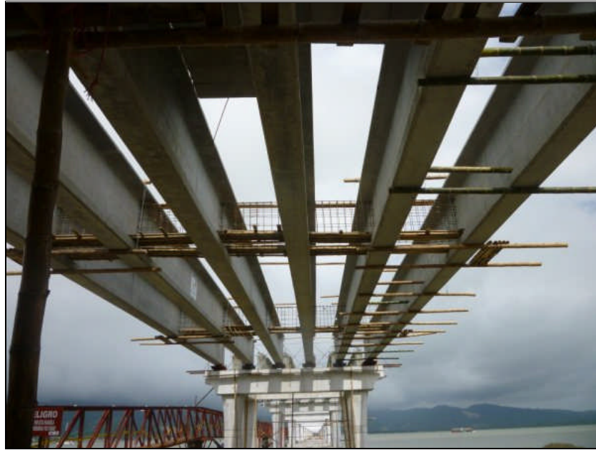
Fig. 2.8 Avances en el puente Bahía - San Vicente actualmente terminado
