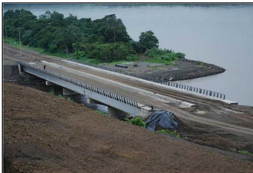
Fig. 2.7 Puente sobre estuario Rio Esmeraldas, Provincia de Esmeraldas
