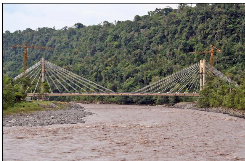
Fig. 2.12 Puente sobre el Rio Pastaza, Provincia de Morona Santiago
