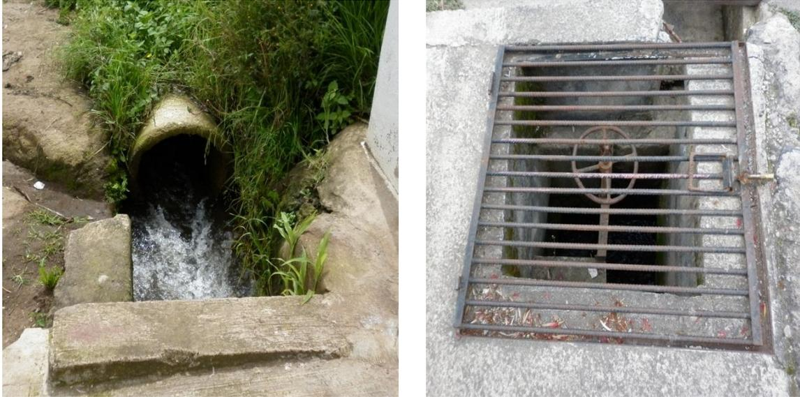
**Figura 2.2 Tubería para conducción de agua de riego y compuerta para control**
