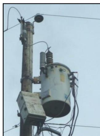
Figura 2. 4. Analizador conectado al transformador en Isabela<sup>155</sup>
