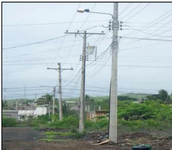
Figura 2. 9. Tendido eléctrico 13.2 [kV], Cerro Cantera de Piedra<sup>162</sup>
