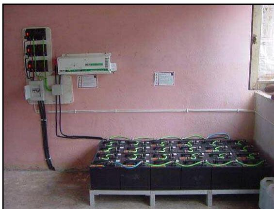
**Figura 1. 16. Banco de baterías solares para un sistema fotovoltaico<sup>43</sup>**
