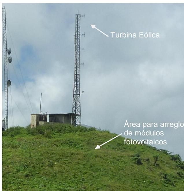
**Figura 2. 23. Zona determinada para implantación de arreglo de módulos fv y generador eólico<sup>182</sup>**
