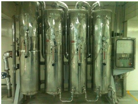
Fig. 2 Destilador de agua OLSA QV 2000
