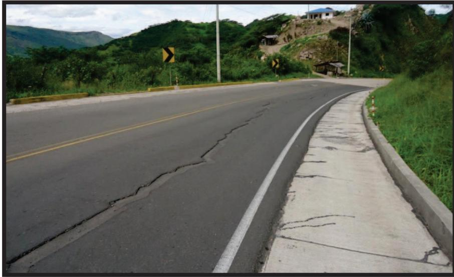
Fig. 5.4 Imagen vía Salado Lentag con recapeo de Asfalto
