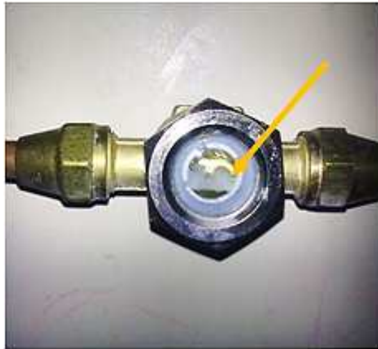
Figura 2.12 Burbujas en el visor de líquido
