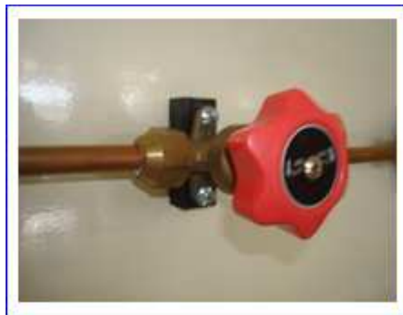
Figura 4.16 Válvula de paso usada en el sistema de refrigeración
