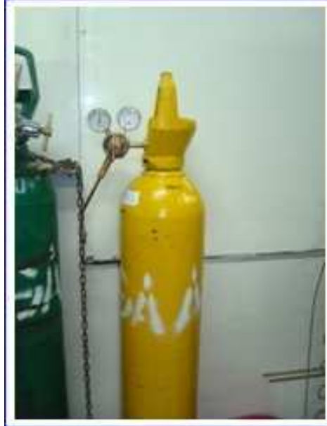
Figura 4.31 Tanque de Nitrógeno usado para presurizar el sistema
