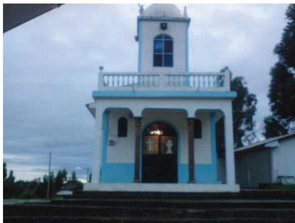
Figura 2.17 Iglesia de la comunidad Carpintería, 19 Feb 2012
