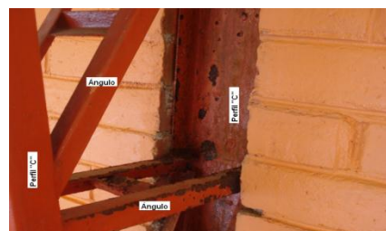
Figura 4.3 Pórtico exterior 1 en sentido transversal
