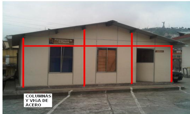
Figura 2.8 Columnas y vigas de acero a colocarse en los pórticos exteriores.
