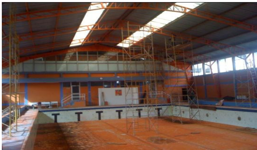
Figura 4.1 Estructura tipo cercha original antes del reforzamiento.
