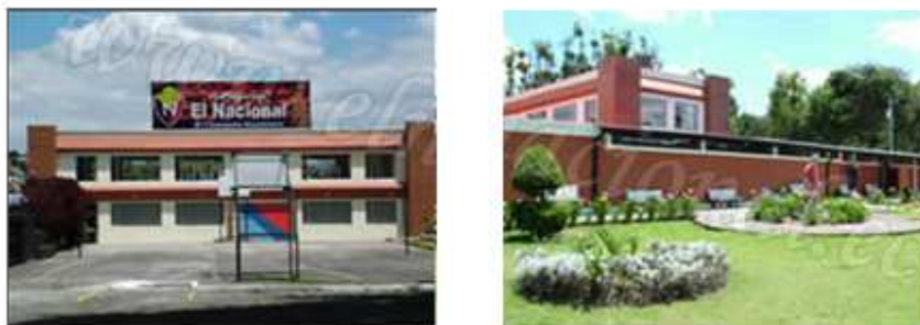
Figura 4: Fachada de la entrada principal al complejo
