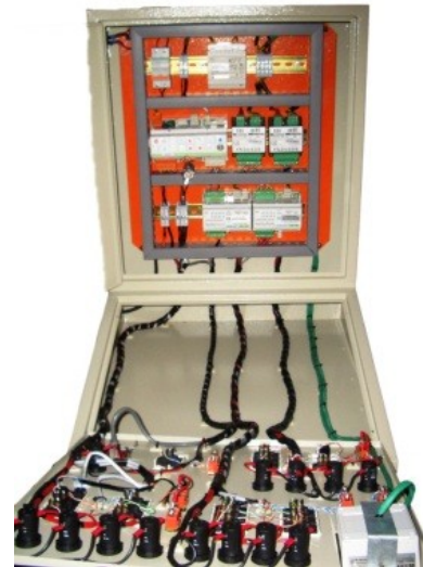
Figura. 4 Distribución del Cableado.
