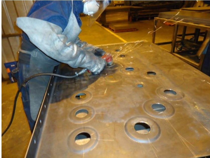
Figura 3.4 Frente de Transformador Perforado
