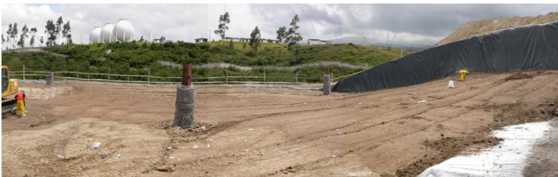
Figura 2.13 Chimenea de biogás
