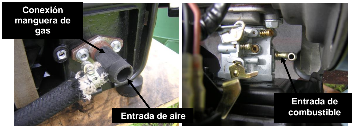
Figura 5.33 Conexión de la manguera de gas en la unidad de generación
