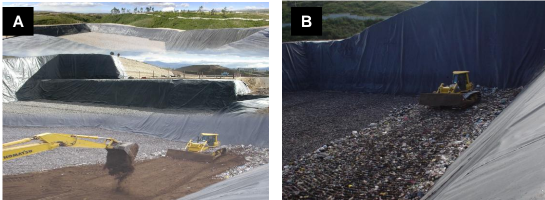
Figura 2.10 Parámetros de construcción R. S. “El Inga”: a) Asentamiento de tierra, b) Tendido y posterior compactación de basura
