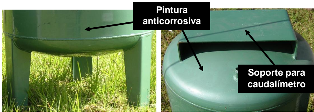
Figura 5.9 Soporte y pintura anticorrosiva
