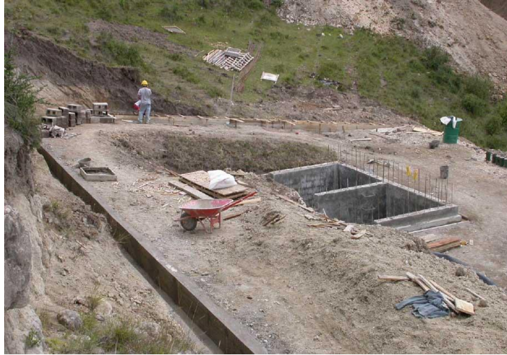
Figura 2.12 Fase de construcción de tanques y de recolección de lixiviados
