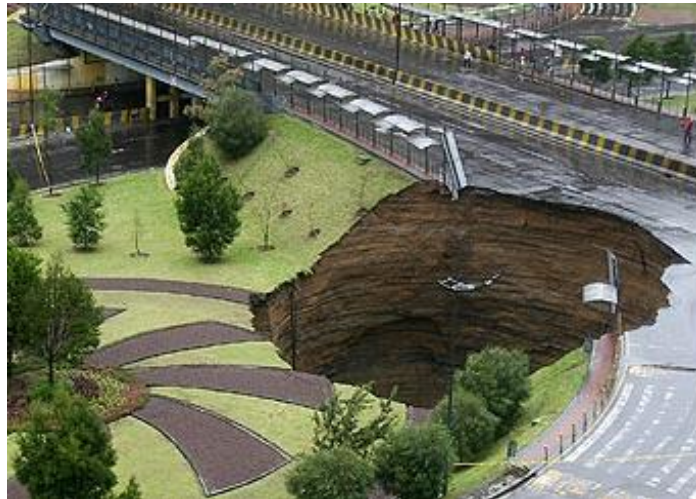
Figura 2. Hundimiento Intercambiador del Trébol
