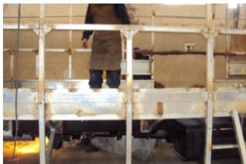
Fig. 1.23.- Juntas zonas laterales, soportes ventanas.
