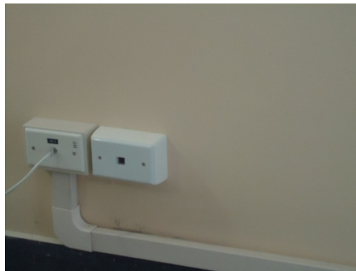
Figura 3. 20: Instalación de Faceplates y Ponchado de Jack
