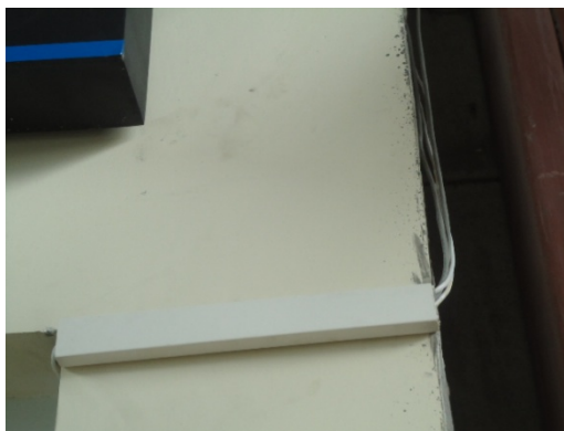
Figura 3. 19: Instalación del cable UTP Cat 5e
