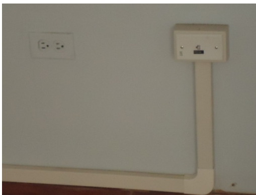
Figura 3. 18: Instalación de cables para el Sistema Eléctrico
