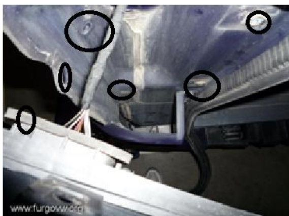
Figura N° 17: Donde podemos cortar los cables positivo y negativo
