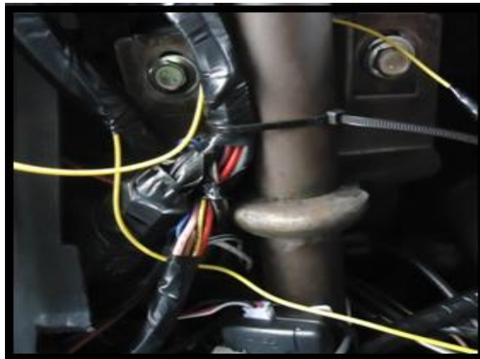
Figura N° 54: Colocación del fusible y la corriente
