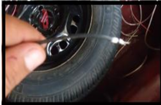
Figura N° 63: Paso del cableado
