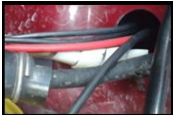
Figura N° 60: Conexión de los cables para la batería Elaborado por: El Autor
