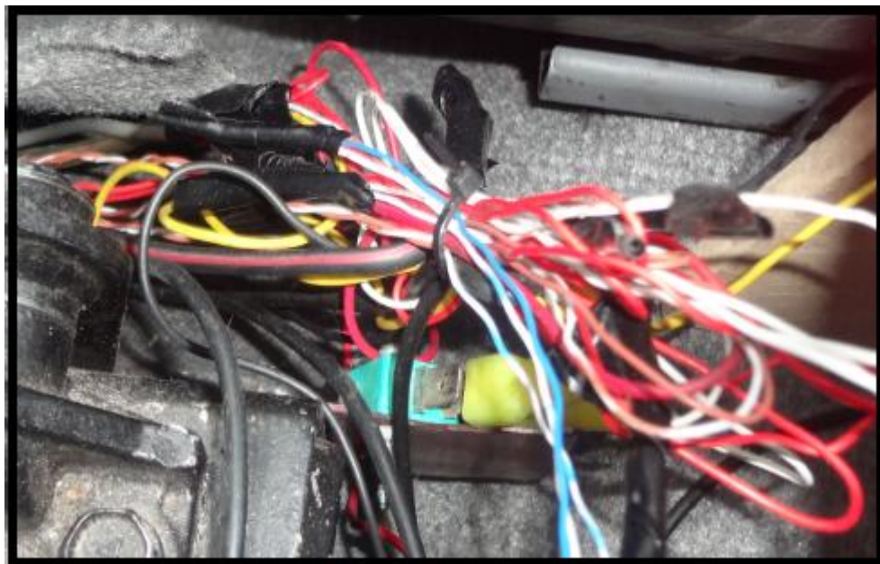
Figura N° 48: Conexión de la tarjeta con el cableado
