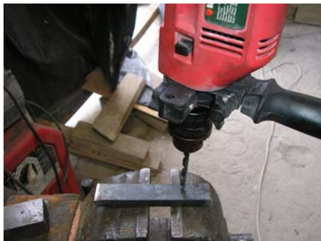
FIG. 4.21 CONSTRUCCIÓN DE LAS PLACAS PARA SOPORTE DEL MOTOREDUCTOR
