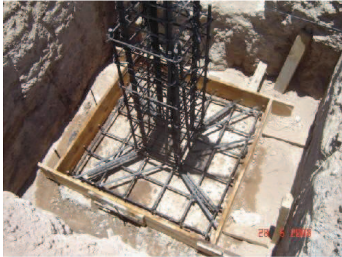
Figura 3.2 : Construcción Zapata Aislada.
