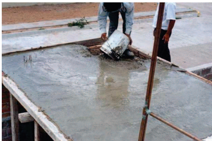
Figura 4.6 : losa Maciza Bidireccional
