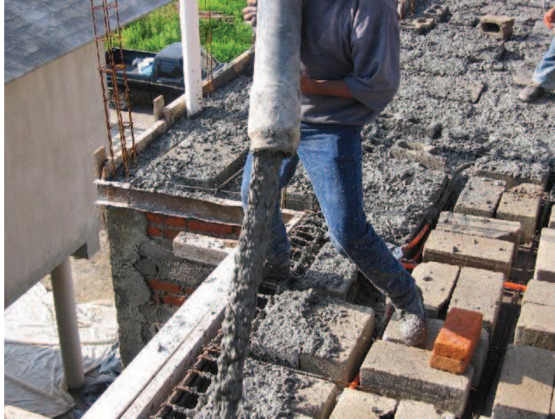
Figura 4.4 : Losa alivianada bidireccional sustentada en columnas
