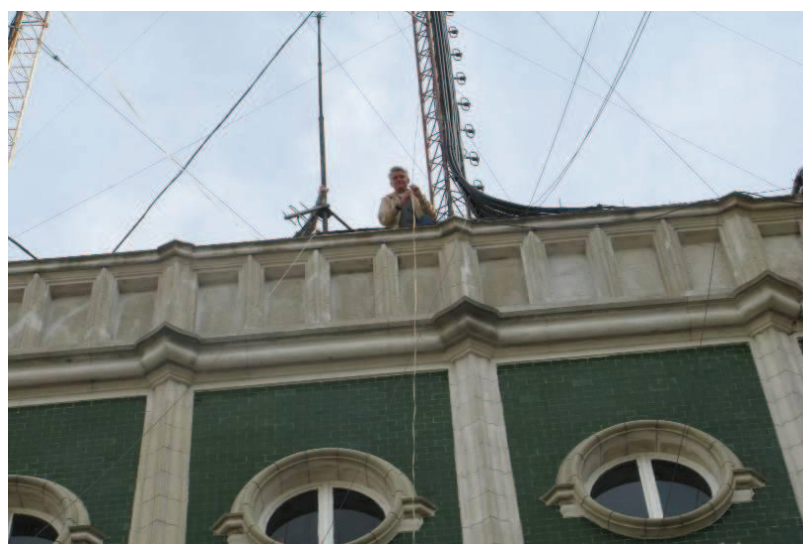
Figura 5.9: Instalación eléctrica aérea o línea abierta.
