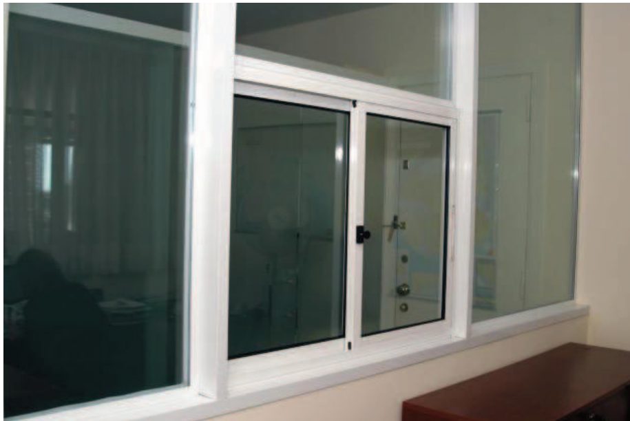
Figura 6.9: Vidriería, Instalación de Ventanas.
