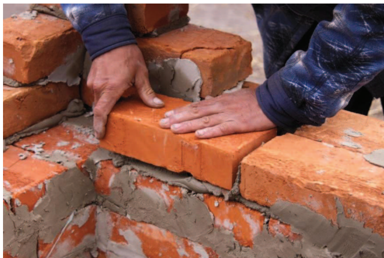
Figura 6.2: Instalación de Mampostería de Ladrillo.
