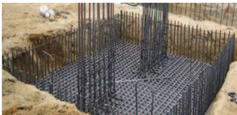
Figura 3.3 : Construcción de Zapata Combinada.
