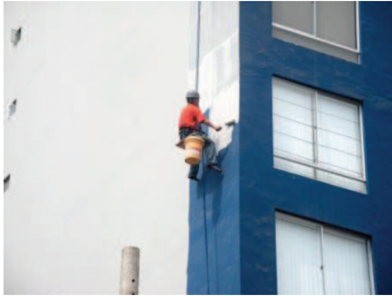
Figura 6.3: Pintura de Exteriores, para proteger el concreto.
