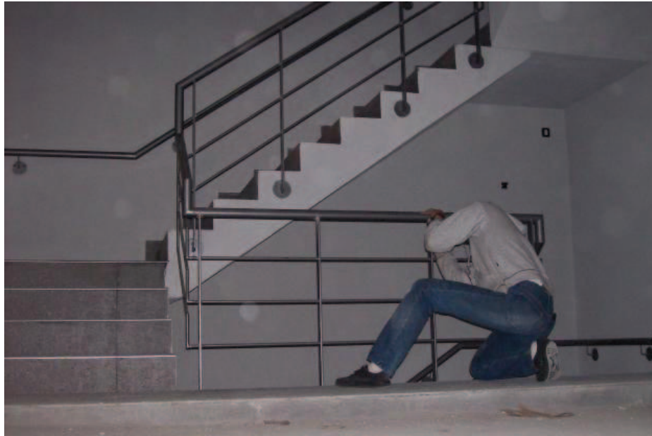
Figura 6.7: Carpintería Metálica, Instalación de Pasamanos.
