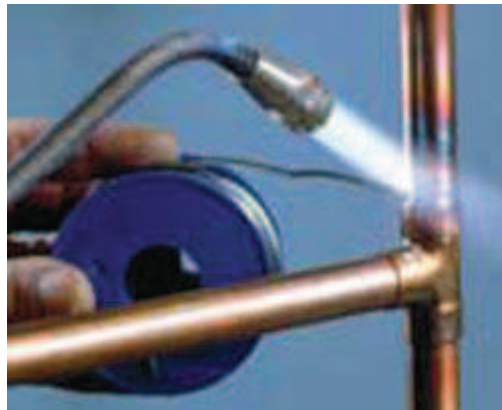
Figura 5.3: Instalación de tubería de cobre.
