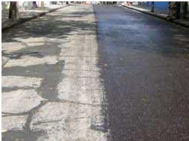
Figura 2.2: Micropavimento sobre Riego de Gravilla (Fuente: [www.bitumixcvv.cl](http://www.bitumixcvv.cl))
