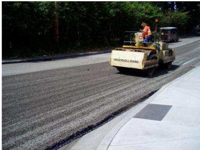
Figura 2.3: Micropavimento distribuido en capas
