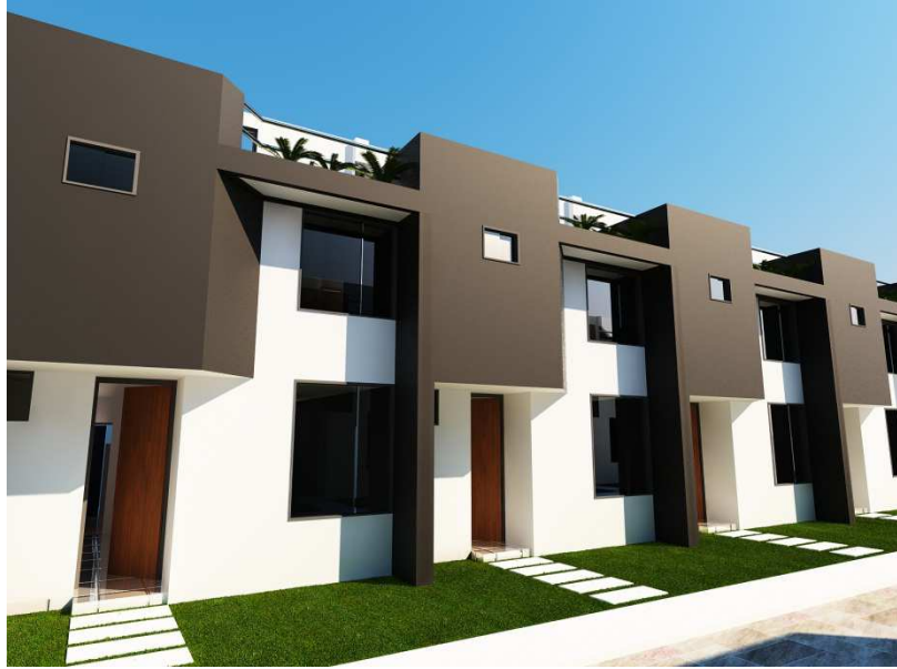
Imagen No. 7: Fachada Principal– Conjunto Villa Nova Fuente: Moncayo & Roggiero Ingenieros Asociados Cía. Ltda.
