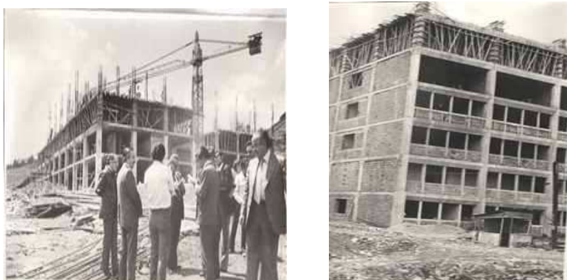
Figura 2. Construcción del Hospital “Enrique Garcés”
