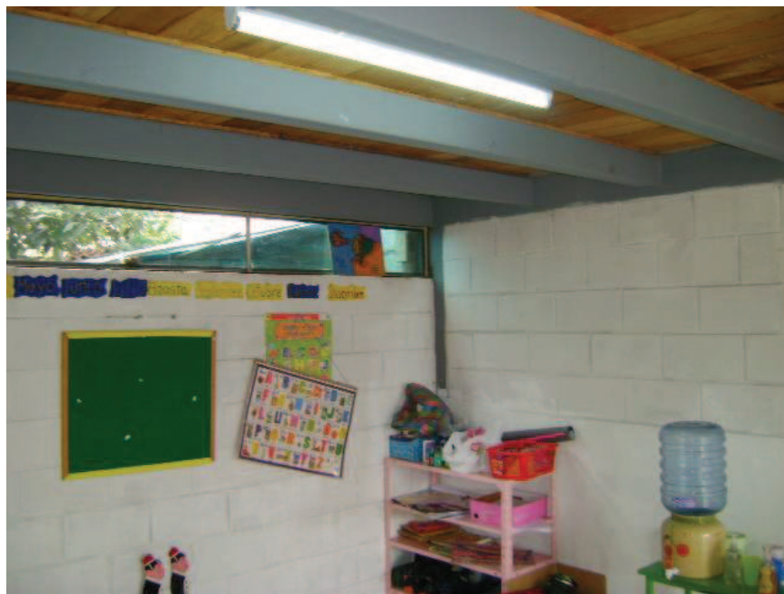
Figura 4.16: Cambio de luminarias (Después)
