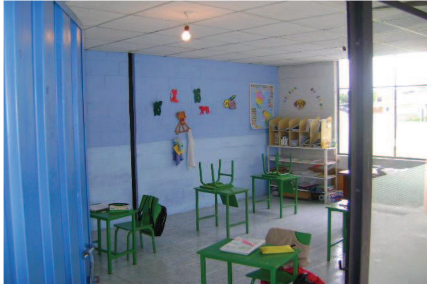
Figura 4.15: Cambio de luminarias (Antes)
