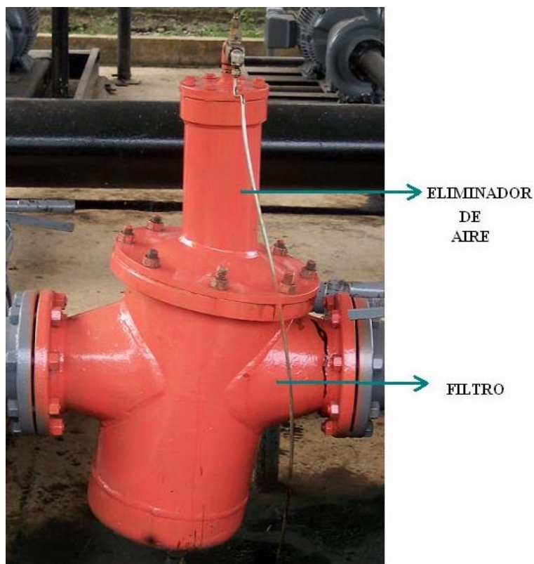
Figura. 2.19 Eliminador de aire acoplado al filtro
