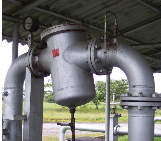
Figura. 3.4 Sistema de filtros
