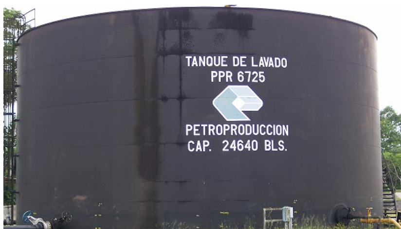
Figura. 2.9 Tanque de lavado
