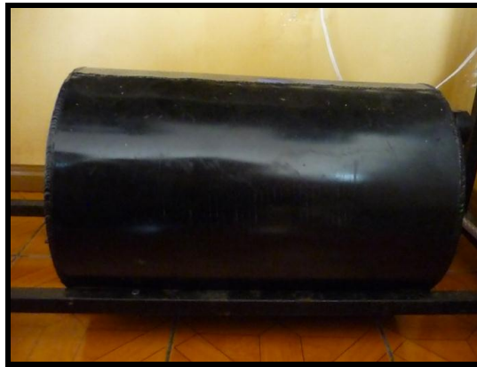
Figura 3.12. Instalación del tanque reservorio
