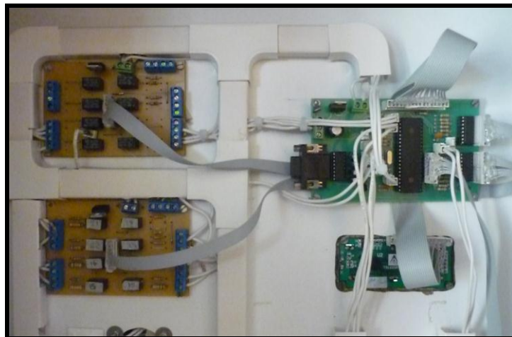
Figura 3.9. Placas instaladas en el tablero
