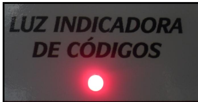
Figura 4.1. Luz indicadora de fallas
