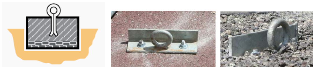
Figura 3.5. Soporte de hormigón para la torre
