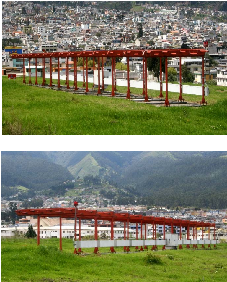
Figura 1.2. Antenas localizadoras instaladas en el AIMS
