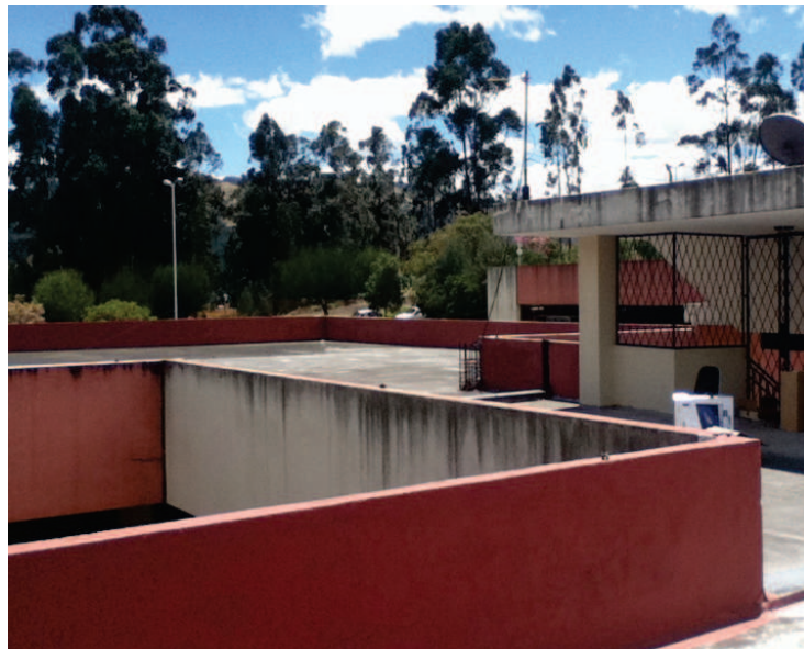
Figura 5.13: Ubicación de Equipos Prueba Exteriores No.2
