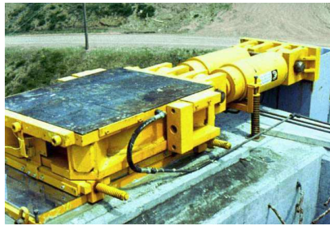
Figura 1.19 Desplazamiento de vigas con gatos hidráulicos
