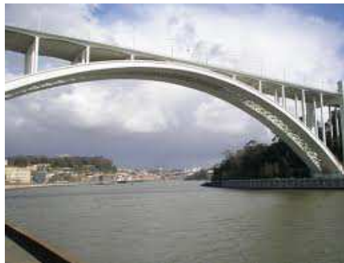
Figura 1.5 Puente tipo arco.
