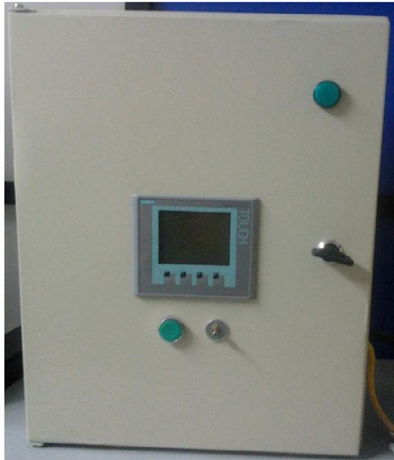
**Figura 4. 6 Puerta de caja térmica con accesorios. Fuente propia.**
