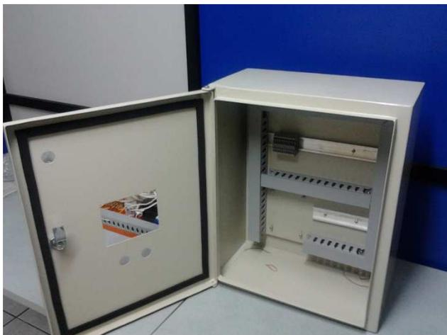
**Figura 4. 4 Caja eléctrica con rieles DIN. Fuente propia.**
