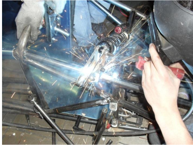
Figura 5.13. Soldado de Bases de Rocker y Amortiguador (Fuente: Grupo investigador)
