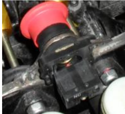
Figura 3.56. Interruptor de parada de emergencia (Fuente: Grupo Investigador)
