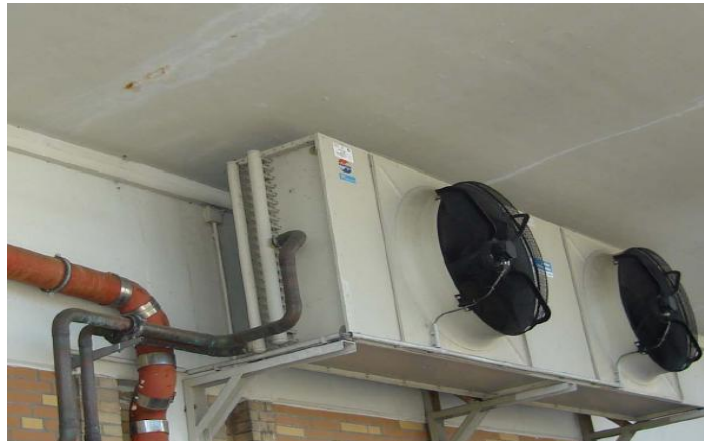
Figura 2.15: Enfriador por aire Fuente: Empresa Tesalia
