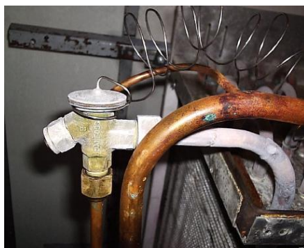
Figura 2.24: Válvula de expansión termostática Fuente: http://refrielectric.wordpress.com
