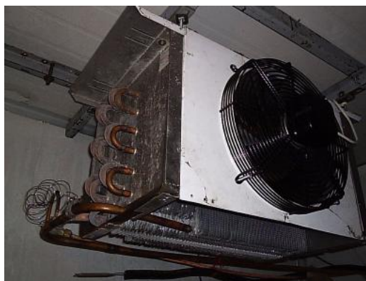
Figura 2.22: Evaporador de serpentín aleteado Fuente: http://es.wikipedia.org/wiki/Evaporador
