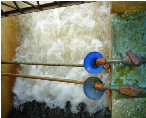
Foto N° 2.3: Colocación del Sulfato de Aluminio
