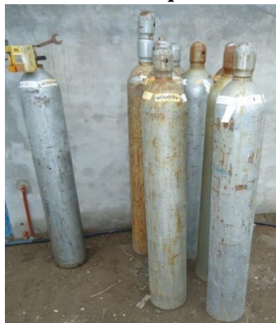
Foto N° 2.11: Tanques de Cloro Gas
