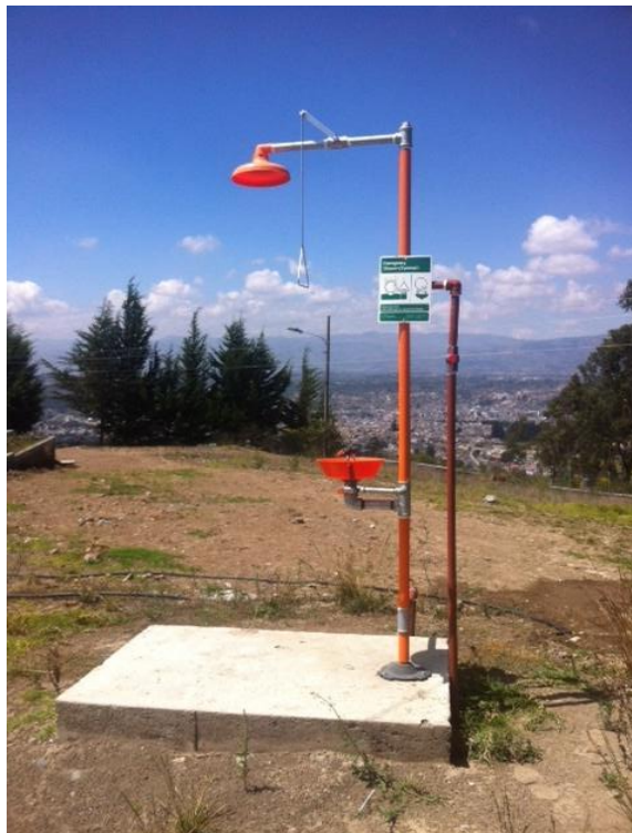
Foto N° 2.12: Ducha para desinfectar al personal infectado de cloro gas
