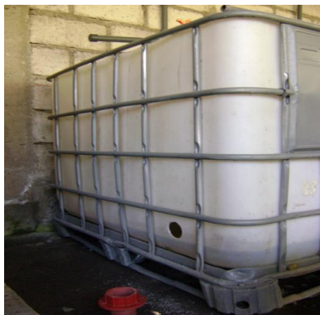
PERFORACIÓN PARA TUBERÍA DE SENSOR DE NIVEL
