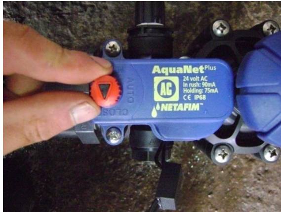
Operación electroválvula forma manual (CLOSE).
