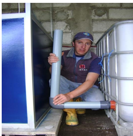
COLOCACIÓN DE TUBERÍA PARA SENSOR DE NIVEL
