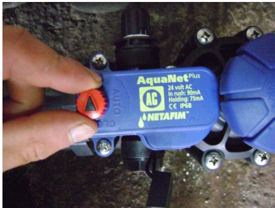
Operación electroválvula forma manual (OPEN).
