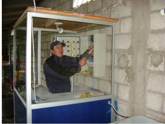
COLOCACIÓN DE TABLERO DE CONTROL
