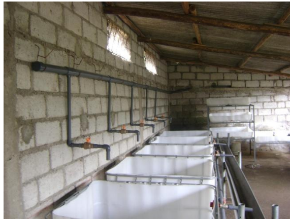
SUJECCIÓN DE TUBERÍA DE ENTRADA DE AGUA
