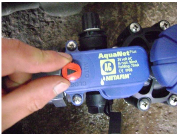
Operación electroválvula forma manual (OPEN).
