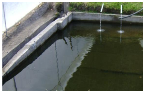
Figura. 1.16 Estanques de hormigón o concreto armado
