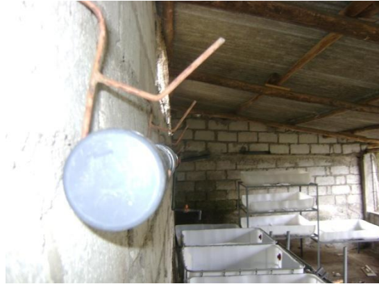
SUJECCIÓN DE TUBERÍA DE ENTRADA DE AGUA
