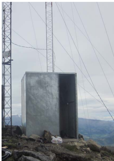
Figura 4.1: Shelter de Telecomunicaciones [A]
