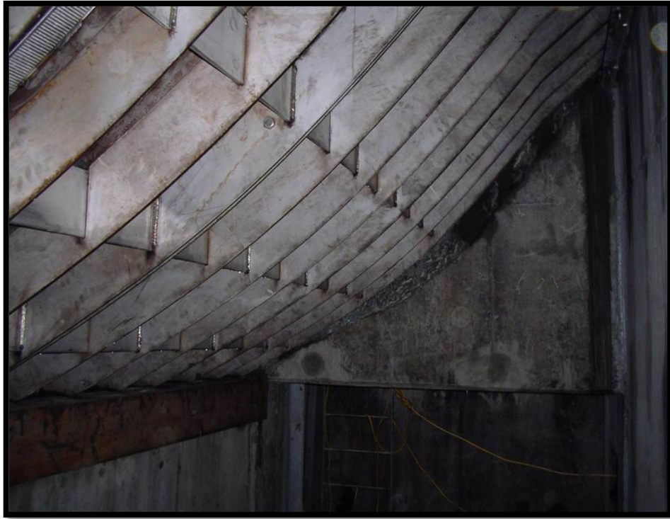
Foto 2.6: Parte inferior de la malla autolimpiante 18 .
