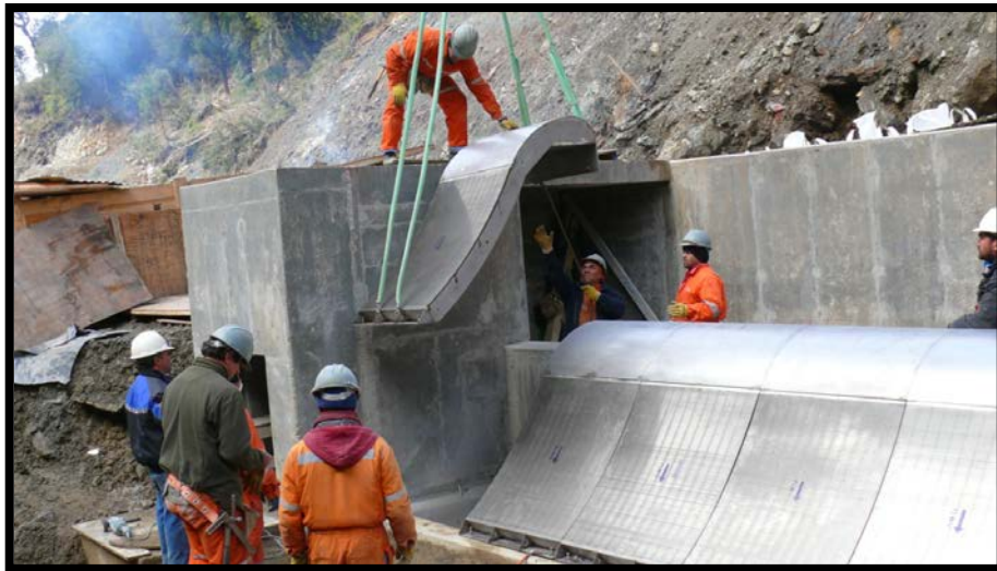
Foto 2.5: Proceso de colación de una malla autolimpiante 17 .
