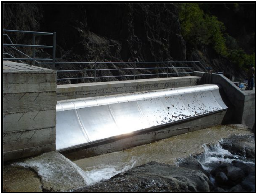
Foto 2.7: Obra terminada de una obra de captación que emplea el efecto Coanda 19 .
