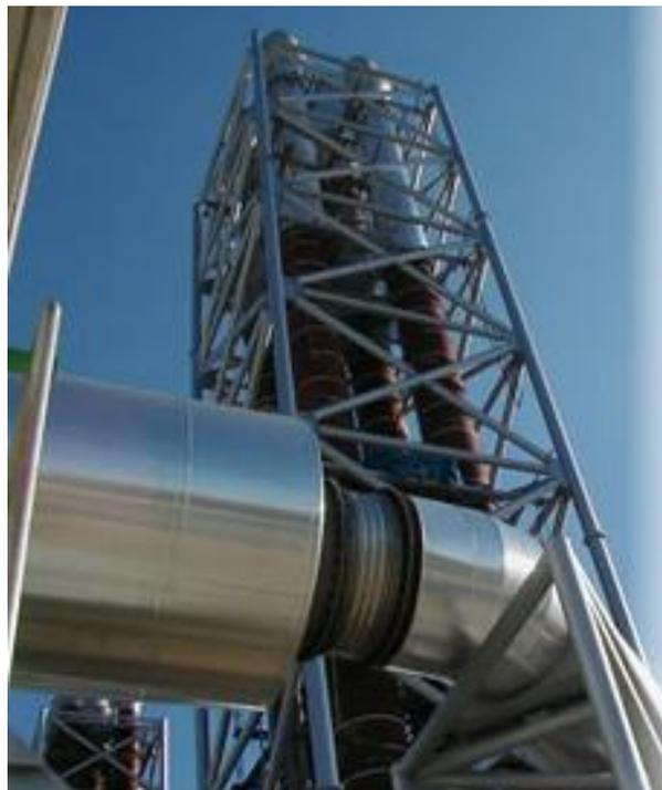
Figura 2.19 Torre del silenciador (exhaust system)
