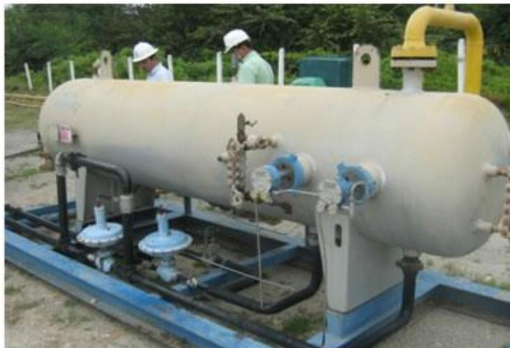
Figura 2.12 Separador Trifásico Horizontal soportado en un skid
