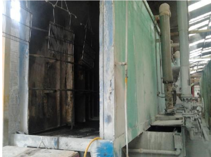
Figura 3.10. Inicio del Proceso de Pre-tratamiento químico y pintura.
