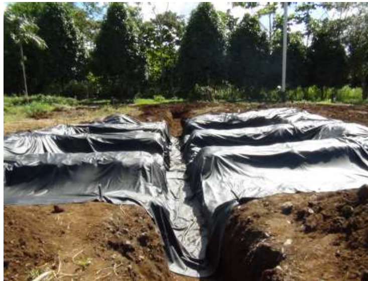
Figura 2.2 Fotografía de la estructura de la plataforma cubierta con geomembrana (Musso, 2012).
