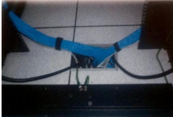
**Ilustración 3.31 Conexión Cableado Estructurado bajo piso falso**
