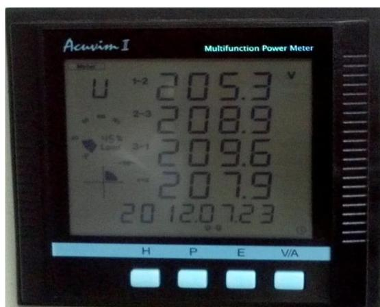
**Ilustración 3.7 Voltajes del Tablero de Distribución amperímetro digital**
