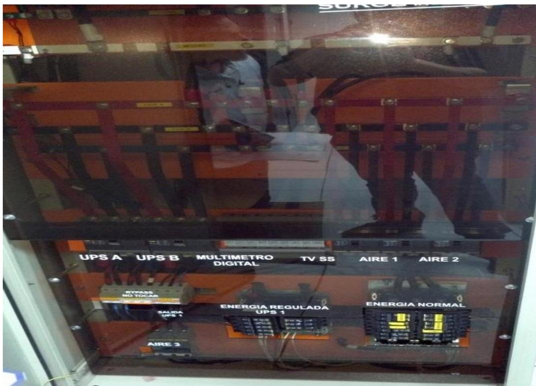
**Ilustración 3.5 Tablero de Distribución Data Center ESPE**
