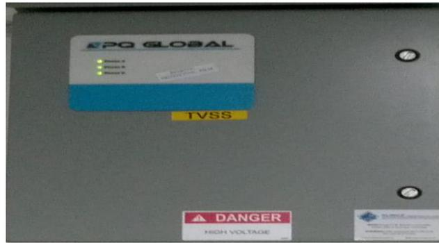
**Ilustración 3.8 TVSS supresor de Picos del Data Center ESPE**
