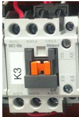
Figura 2. 38 Contactor trifásico marca LG
