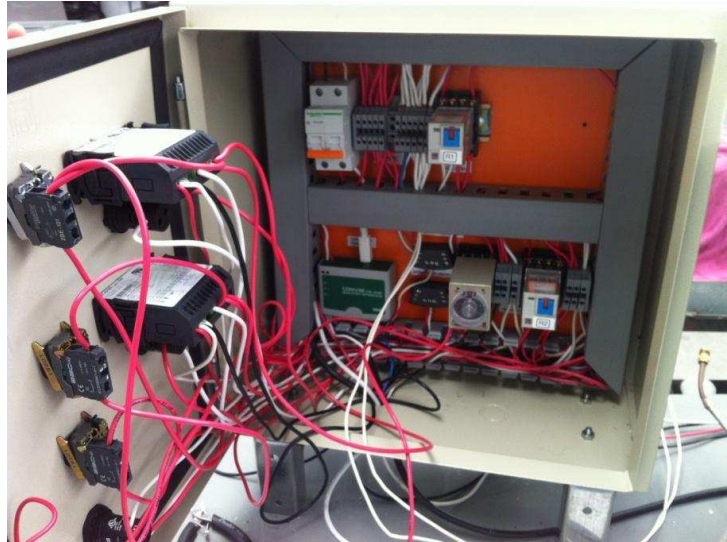
Figura 3. 34 Instalación y cableado del sistema eléctrico
