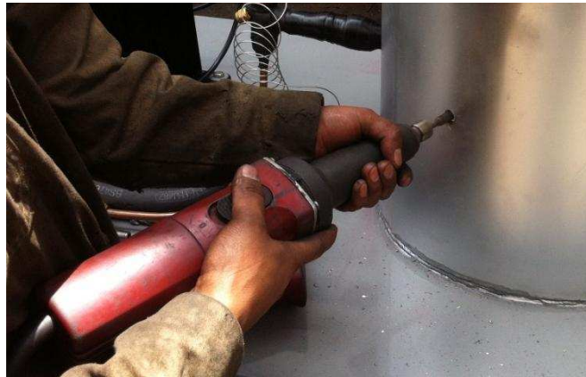
Figura 3. 38 Perforación para tubería de sensores
