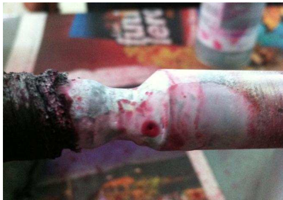
Figura 4. 4 Manchas formadas por la presencia de poros en la costura
