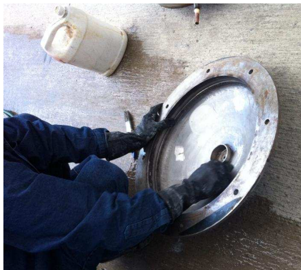
Figura 3. 10 Limpieza del equipo antes de la pintura
