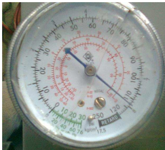
Figura 4. 9 Presión alcanzada del nitrógeno seco dentro de las tuberías
