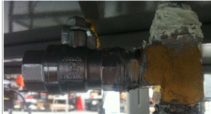
Figura 3. 30 Válvula de 1/2" ajustada a la T de bronce.
