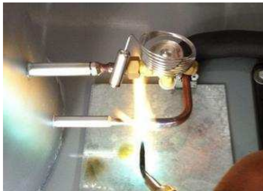
Figura 3. 27 Soldadura de tubería de cobre a la salida del evaporador.
