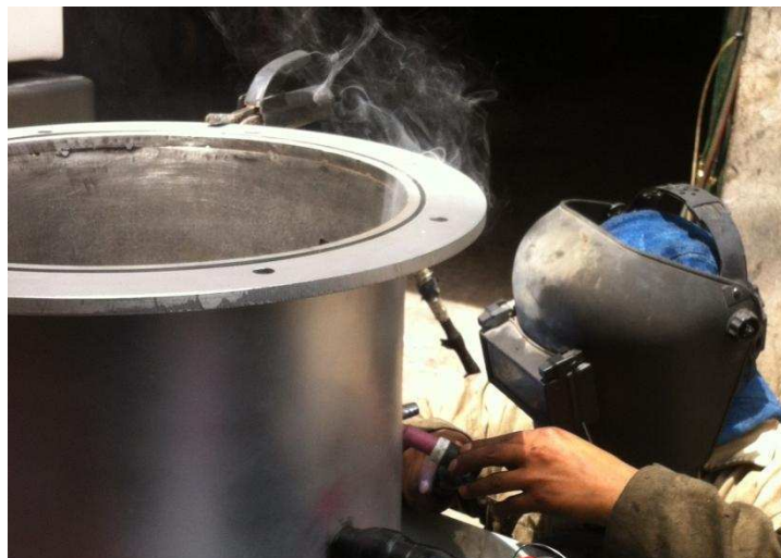
Figura 3. 39 Soldadura de tubería para sensores
