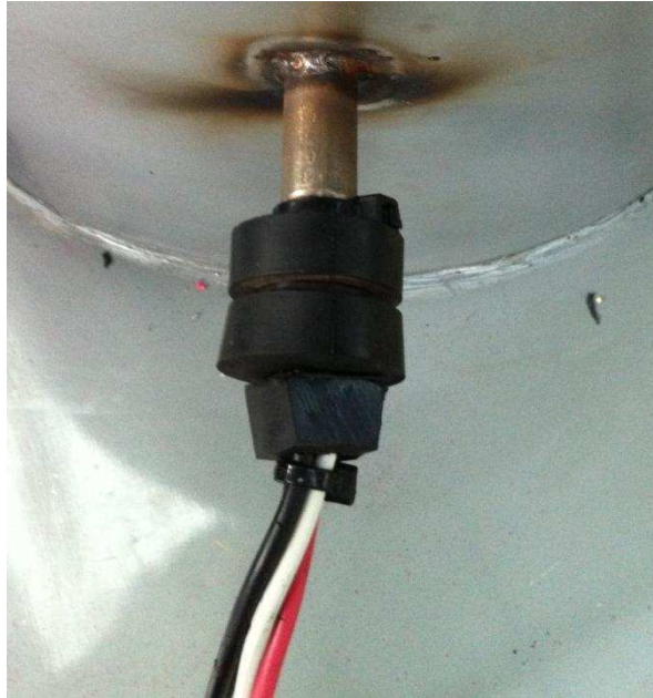
Figura 3. 40 Pasamuros para sensores de temperatura
