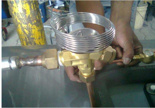
Figura 3. 26 Ubicación válvula de expansión.
