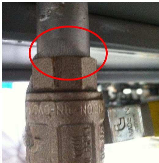
Figura 3. 43 Punto de fuga en unión móvil
