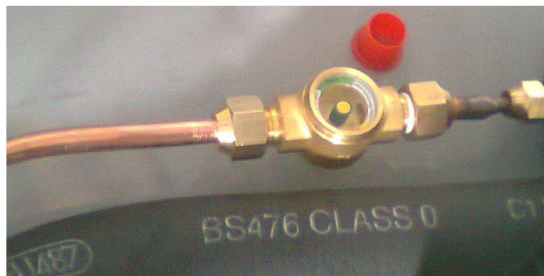
Figura 3. 25 Conexión del visor líquido.
