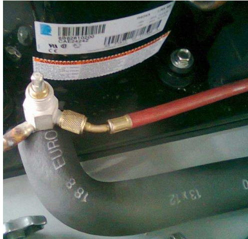
Figura 3. 28 Conexión de tubería de cobre a la entrada del compresor.
