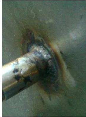
Figura 3. 9 Suelda del acople para bomba de vacío.
