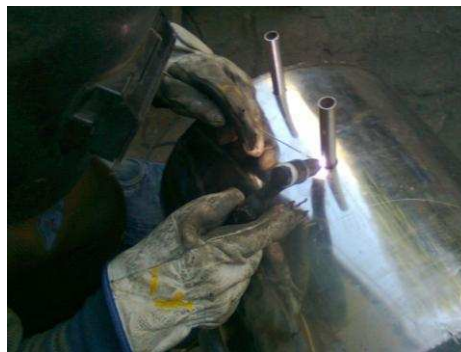
Figura 3. 16 Suelda de tuberías.
