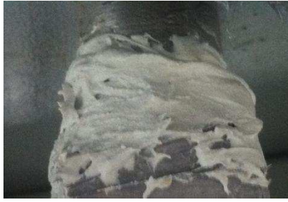
Figura 3. 44 Solución epóxica y silicona en unión movable.
