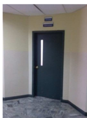
Figura 4.4 Oficina de Servidores
