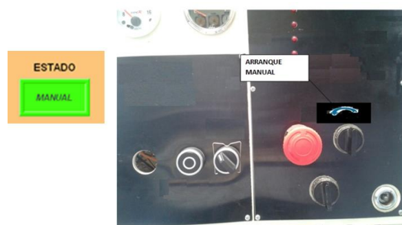
Figura U. 7 Selector SW1 en el panel de operación del G. E.
