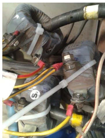
Figura 2. 25: TC´s del generador
