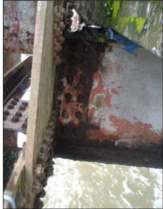
**Fig. 4.2 a) Corrosión viga longitudinal, b) Corrosión vigas de piso**
