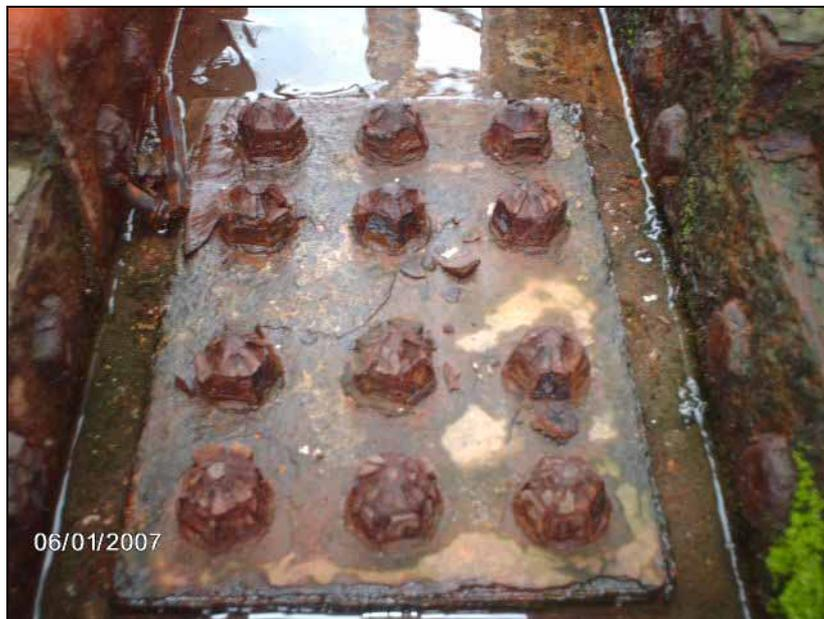
**Fig. 4.3 Pernos deteriorados**
