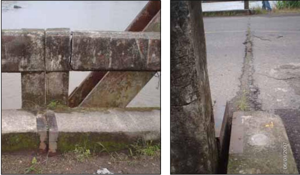
**Fig. 4.4 a) Junta puente de acceso \_ puente metálico, b) Junta vía \_ puente de acceso**
