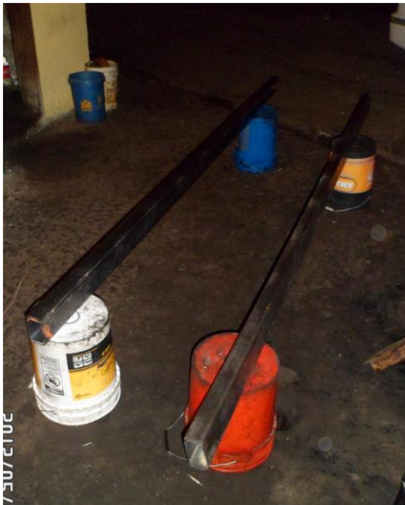
Figura 4. 1 Largueros de la estructura del chasis
