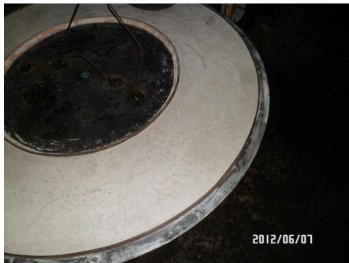
Figura 4. 9 Fundición de cemento en la pista
