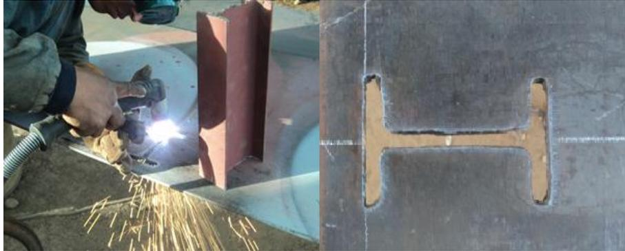
**Figura N° 87:** Corte de plancha naval.<sup>120</sup>
