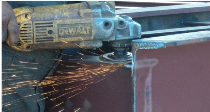
**Figura N° 89:** Preparación de las superficies.<sup>123</sup>
