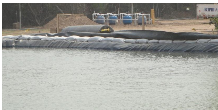
Figura 2.7. Laguna de clarificación.
