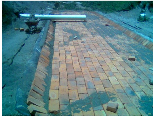
Figura 2.8: Lecho de secado de lodos.
